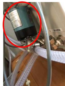
遮断弁が作動し水の供給をSTOPします。
