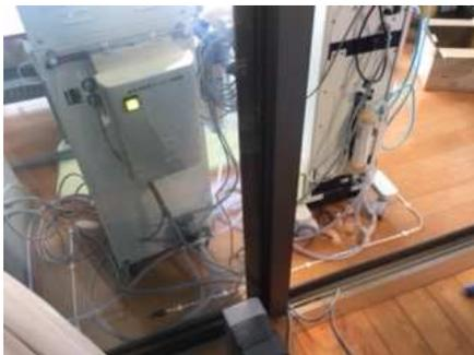
見えづらいですが2台の装置を囲っている白い線が漏水センサーです。
